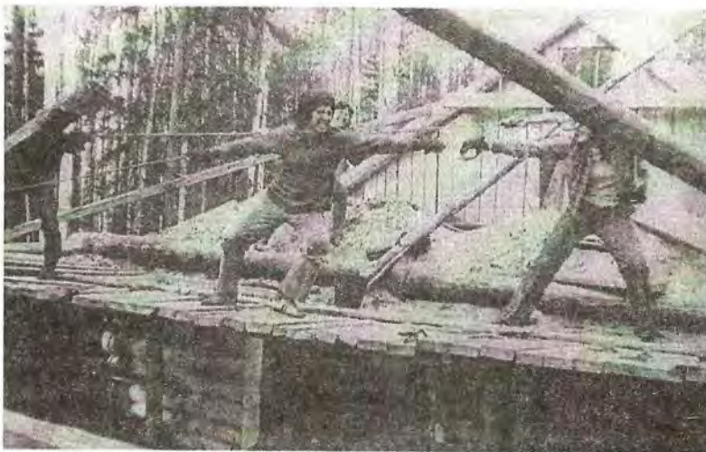
Монтаж крыши избы.
